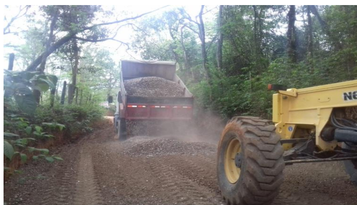
Figura 07: Material reciclado sendo descarregado para viabilizar a manutenção da Rua Saudade, bairro Charneca, Betim, MG. Fonte: Autor, 2018.
