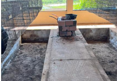
Figura 1. Caixa de compostagem no galpão
