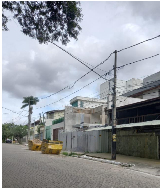
Figura 2 – Residência em obra na Ilha dos Araújos
